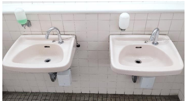
大船駅駅トイレ自動水栓化
